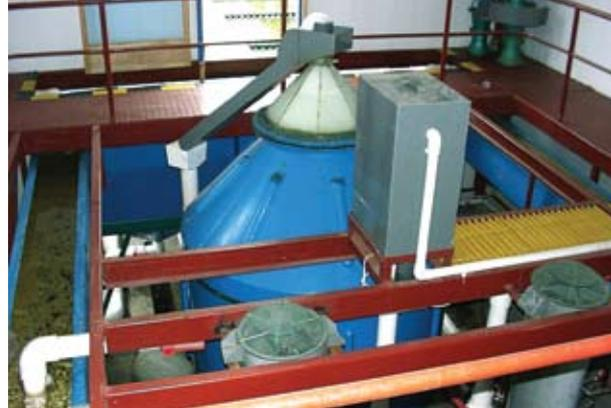
Foto 7 – Vista superior de um fracionador de espuma (estrutura em azul no centro da foto), onde é possível observar a espuma branca no interior da cúpula transparente, bem como a saída da espuma branca por um tubo no topo da cúpula. Esta espuma concentra parte dos sólidos finos e dissolvidos
