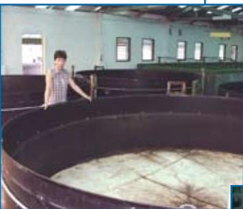
Foto 1 – Tanques circulares com fundo de alvenaria e paredes em PVC usado em sistema de recirculação experimental nas Filipinas. No tanque destacado é possível observar o dreno central
