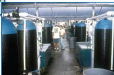
Foto 5 – Tanque usado como filtro biológico, contendo esferas plásticas que servem como substrato para a fixação de bactérias nitrificadoras. No detalhe as esferas do tipo bio-balls
