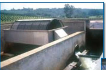
Foto 4 – Bateria de filtros de areia expansível utilizados, com dupla função: remoção de sólidos e filtragem biológica
