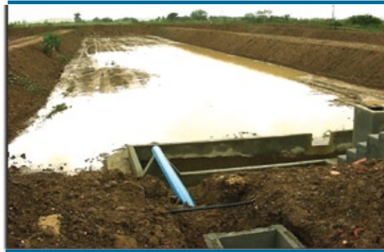
Foto 4 - Viveiro em reforma com o tubo de abastecimento posicionado na caixa de manejo. Observe à direita da foto a escada de acesso à caixa de manejo e ao monge (CODEVASF - EPI - Porto Real do Colégio, AL).
