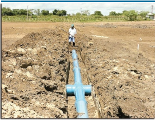
Foto 2 - Instalação da tubulação de abastecimento sobre o dique principal ainda em construção. A tubulação foi posicionada na margem do dique, de forma a ficar fora do tráfego de veículos pesados sobre o dique. Observe a cruzeta na linha principal, da qual serão derivados os tubos de cada viveiro. (CODEVASF - EPI - Porto Real do Colégio, AL).
