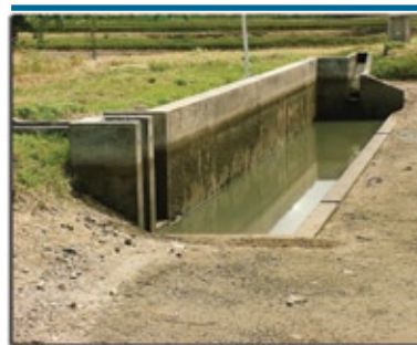
Foto 8 - Caixa de manejo construída em alvenaria. Observe a boa profundidade da caixa e a entrada de água na extremidade da caixa oposta ao monge. No primeiro plano está o monge, que permite o controle do nível de água e a drenagem do viveiro e da caixa de manejo (Estação de Piscicultura da CHESF - Paulo Afonso, BA).
