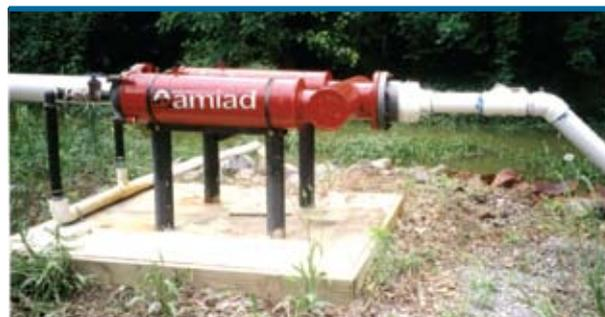
Foto 1c – Antes de retornar aos viveiros, a água bombeada passa por um filtro de telas que é autolimpante.
