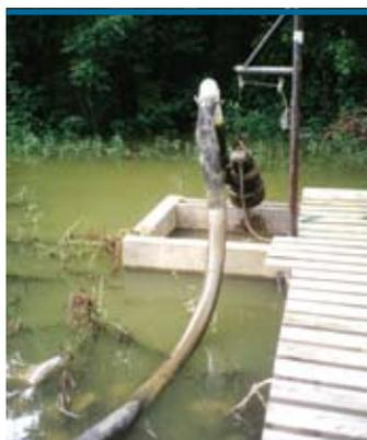
Foto 1b – Detalhe da bomba submersa que retorna a água para os viveiros. A plataforma permite o acesso à bomba e um sistema de roldanas e catraca possibilita içar a bomba para manutenção.
